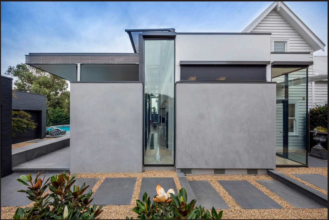
Architect: Latitude Architects | Build: CEA Constructions
